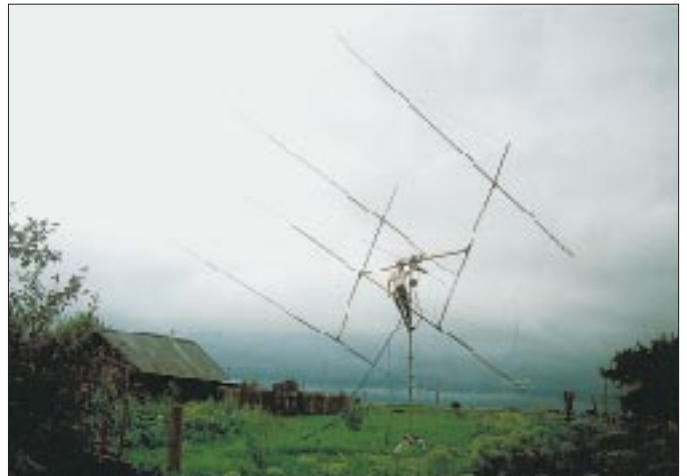
Andy, RV3IG, bei Arbeiten an seiner EME-Antennenanlage, bestehend aus 4 x 16-Ele.-Yagis, jede knapp 9 m lang. Foto via DK3WG
