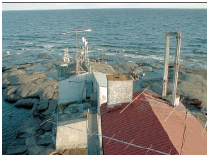
Market Riff mal von oben gesehen: Gut zu erkennen sind die 2- und 6-m-Antenne, dahinter ein 3-Ele.-Beam für Kurzwelle.
