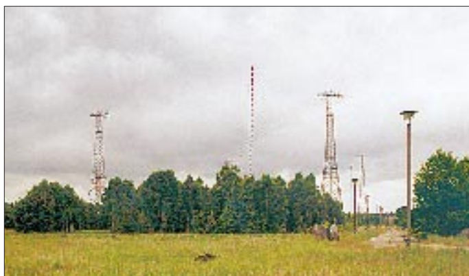
Blick über das weitläufige Areal; in der Bildmitte die Vertikalstrahler. Die Gittermasten gehören zum horizontal polarisierten Dreifach-Dipol mit Nord-Süd-Richtung.
