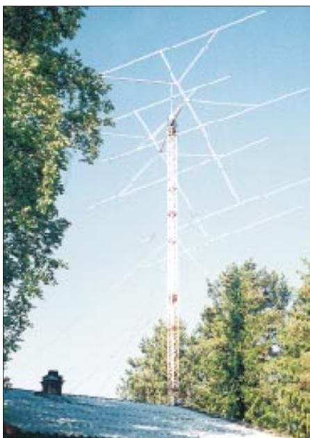
Die Antennenanlage von RU1AA in KP40, die aus 6 x 17-Ele.-Yagis besteht
