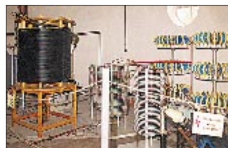
Abstimmereinheit für Längstwelle, links eine Blitzschutzdrossel
